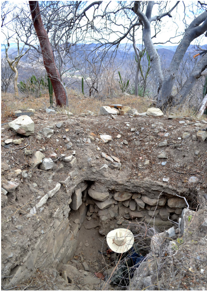
Figura 14. Pozo de saqueo de la tumba del Momoxtle 1 en la Peña. Estos conjuntos de base piramidal están creados a partir de un sistema de piedras basálticas sobrepuestas que cubren cámaras funerarias. Fotografía: Víctor Franco (primavera de 2023).
