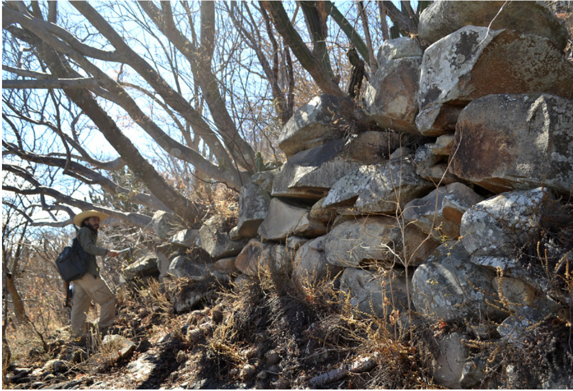
Figura 5. Muro o tecorral de tipo bloque basalto monolítico, usado como sistema defensivo y contención de terrazas en la zona de la Peña. En estas terrazas es común ubicar algunos sillares en su contexto original. Fotografía: Luis Franco (primavera de 2023).
